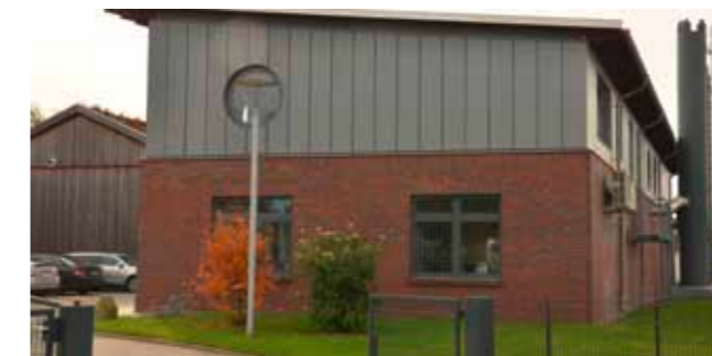
Heizhaus mit BHKW; Gas- und Wärmedienst Börnsen GmbH
