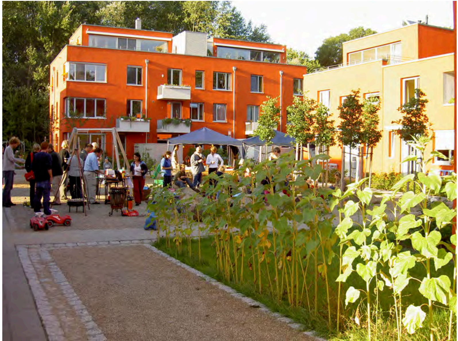
Wohnen an der Hülshorst, Regenwasserrinnen und –versickerung in Mulden (Architekten: Steffens Meyer Franck)
