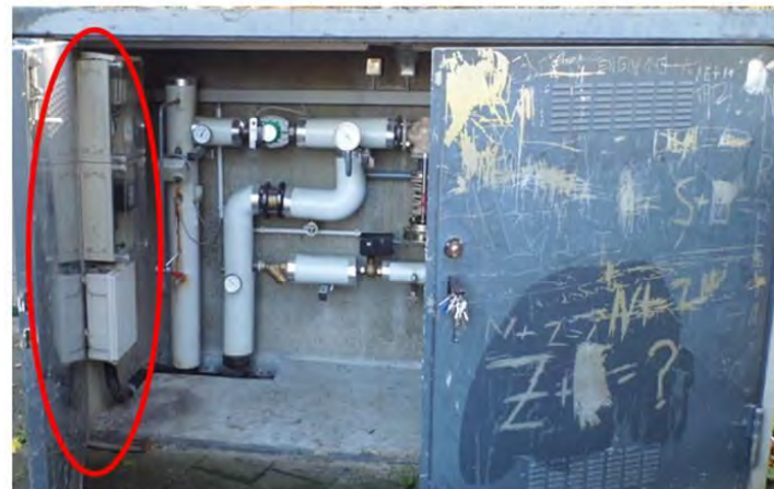
Netzstation Fernwärme (DN 50) Beispiel Erich-Kästner-Str.
